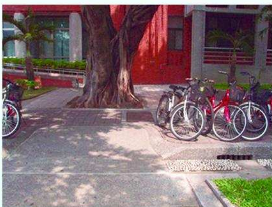
光復校區雲平大樓前 斜坡道入口
